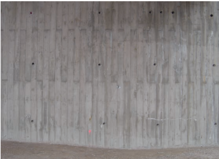
Abbildung 46: Abdrücke einer Bretterschalung
